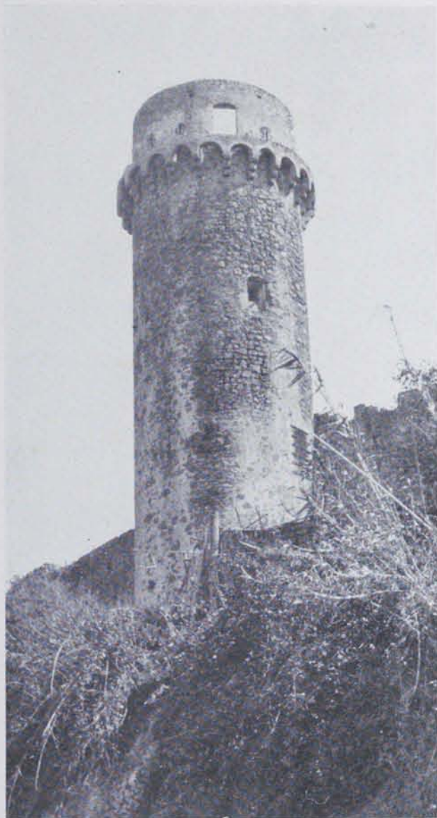
Fig. 329. — Hostalric : Torre de la muralla
