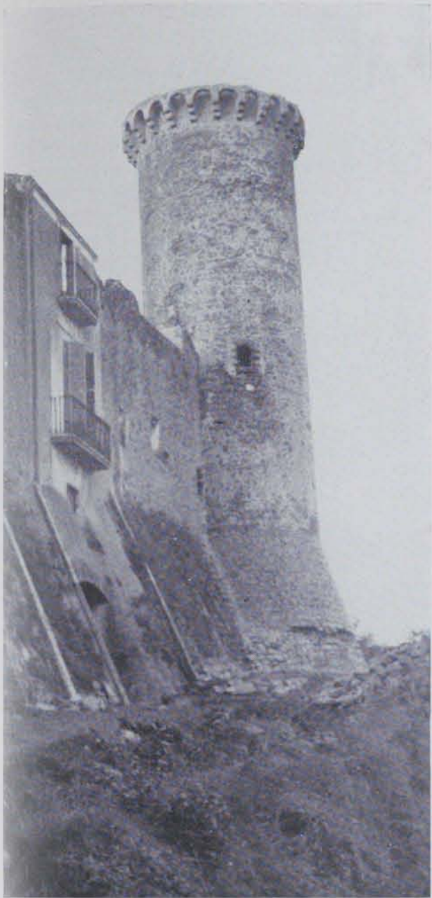
Fig. 328. — Hostalric : Torre de la muralla
